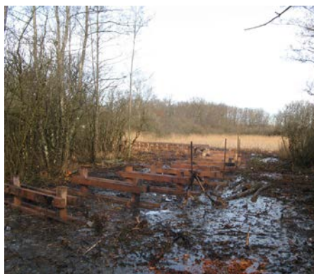
lancement des travaux au Marais de Chilly
