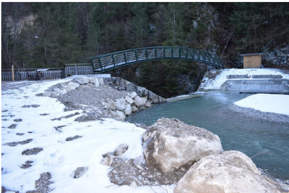
Chute du barrage et nouveau pont Au 1 e plan : enrochement pour protéger la berge.
