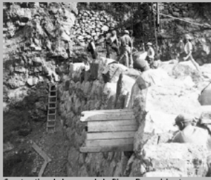
Construction du barrage de la Pierra Bessa, ici entre le 30 juillet et le 08 octobre 1937. Building the Pierra Bessa dam between the 30th July and 8th October 1937.
