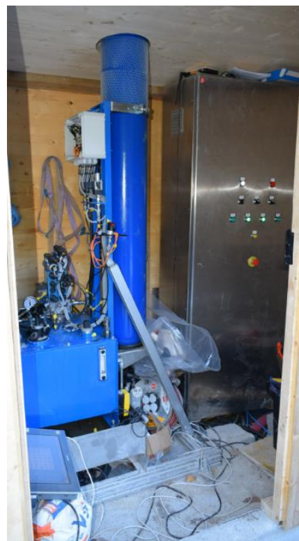
Photo 4 : à l'intérieur du bâtiment >
